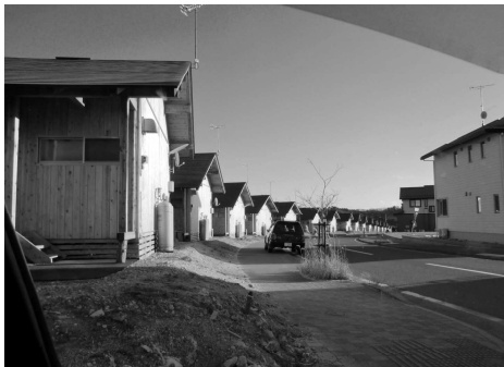
榑葉町住民のための木造仮設住宅。いわき市に集団で移住している。
